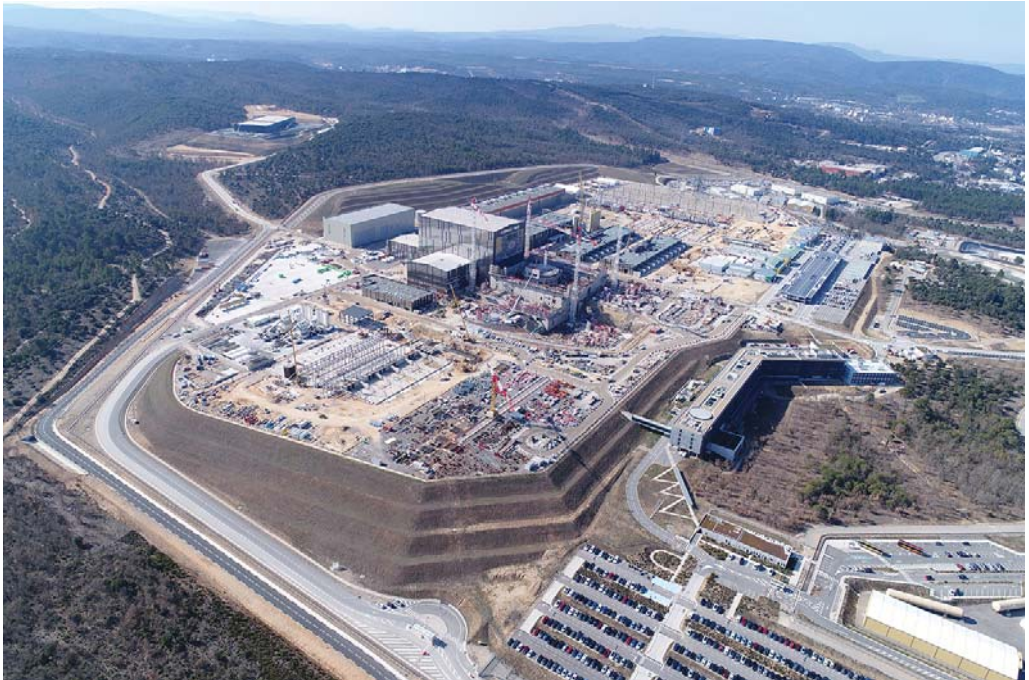
Figure 11. Vue aérienne du site du projet ITER en mars 2018. © Oak Ridge National Laboratory – CC-BY-2.0.
