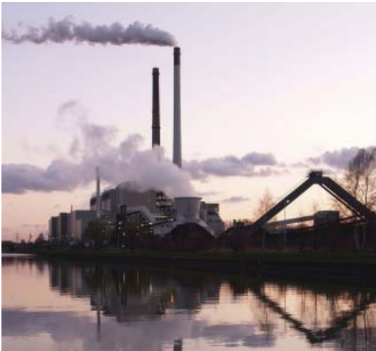
Figure 13. Centrale à charbon. Le \text{CO}_2 pourrait être capté depuis les cheminées. © Arnold Paul – CCBY-SA2.5.
